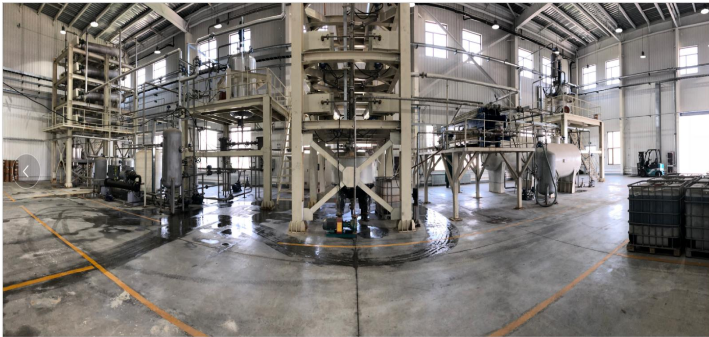
化学法千吨级 废旧PET降解中试车间
